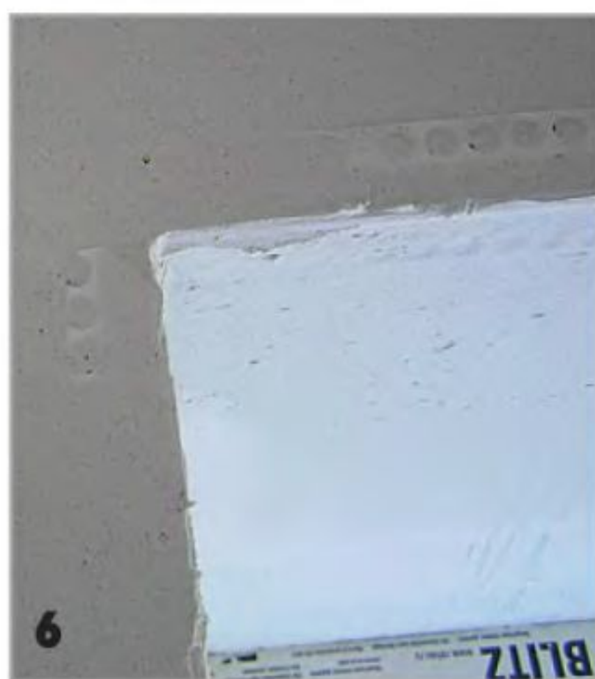
Чтобы углы получились «идеальными», по всему периметру оконного проёма наклеивают штукатурный уголок.
