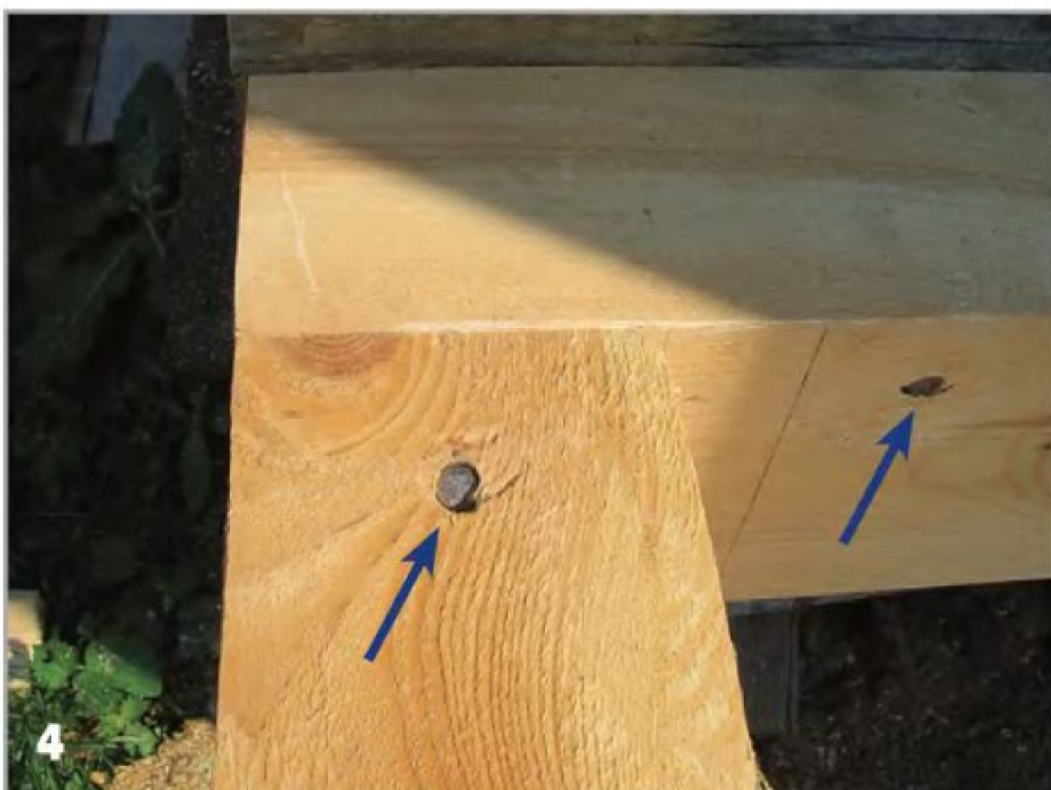
«Замковый шип» (слева) и один из пяти штырей крепления продольной балки к срубу (справа).
