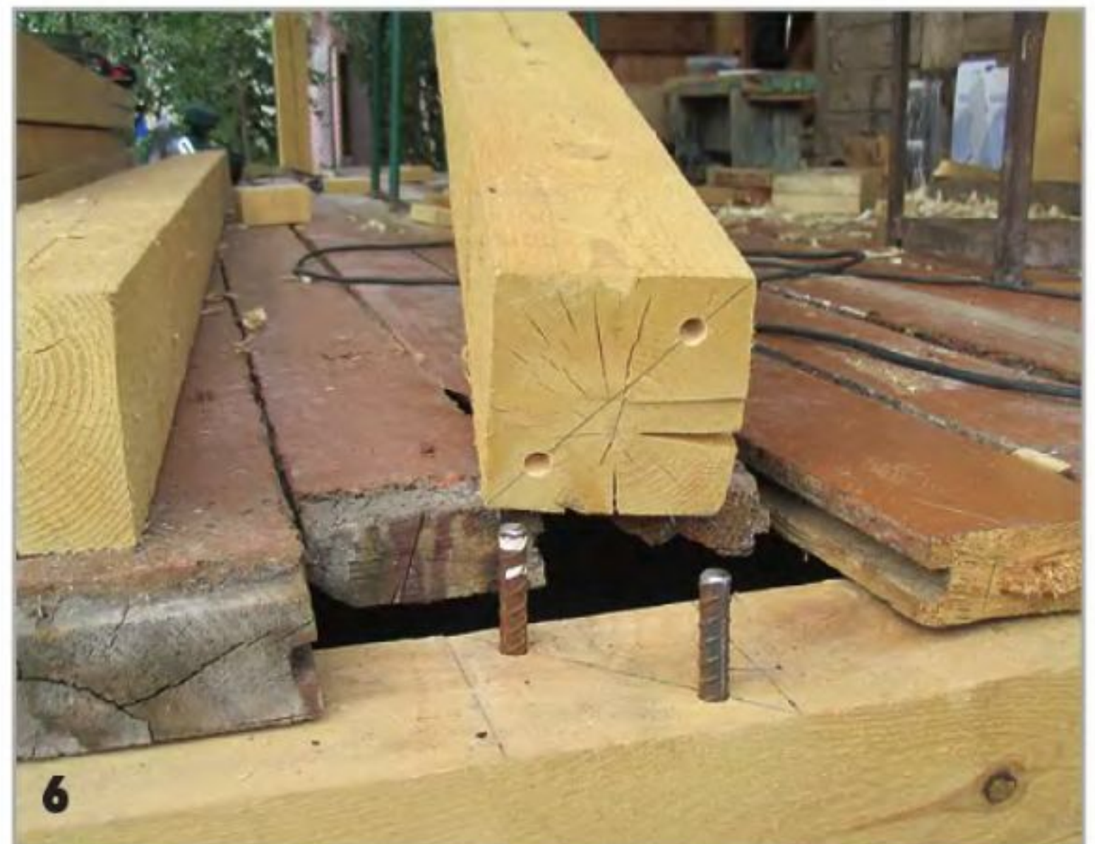
Подготовка к монтажу стоек.
