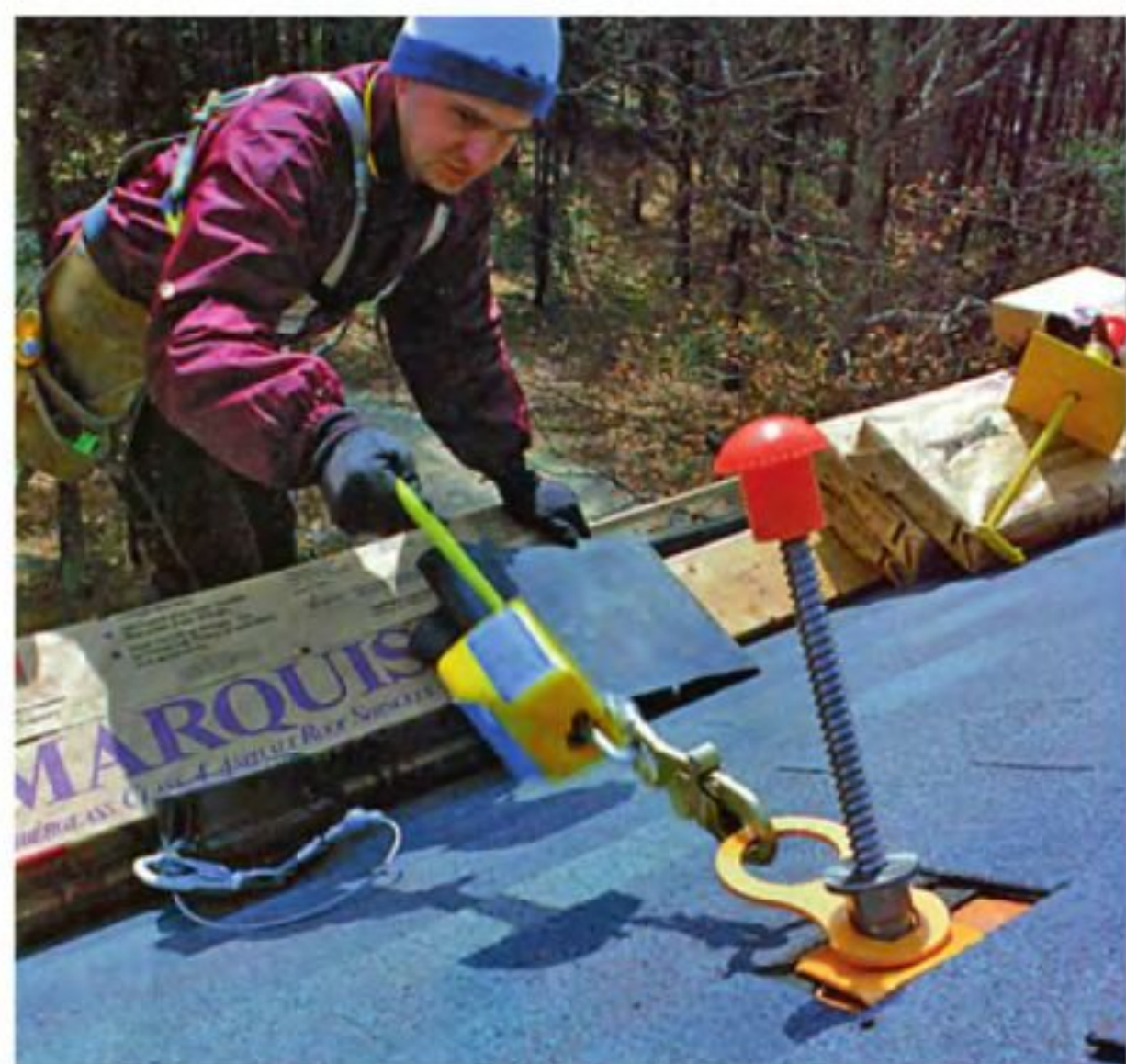
Безопасность работ на крыше
