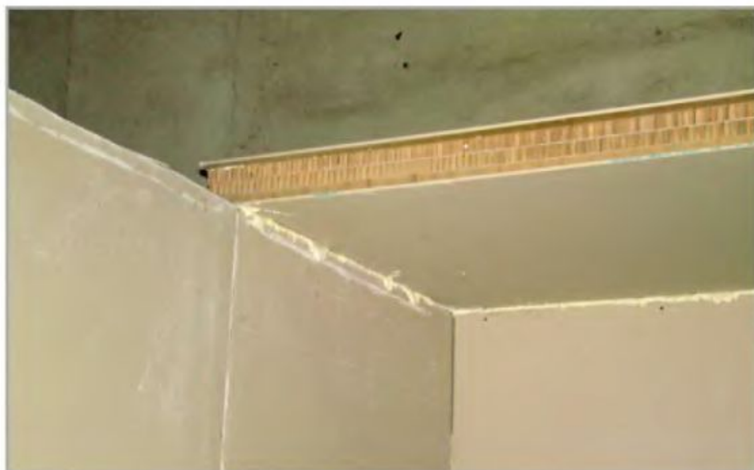
Стеновые панели можно использовать для устройства неэксплуатируемого потолка.
