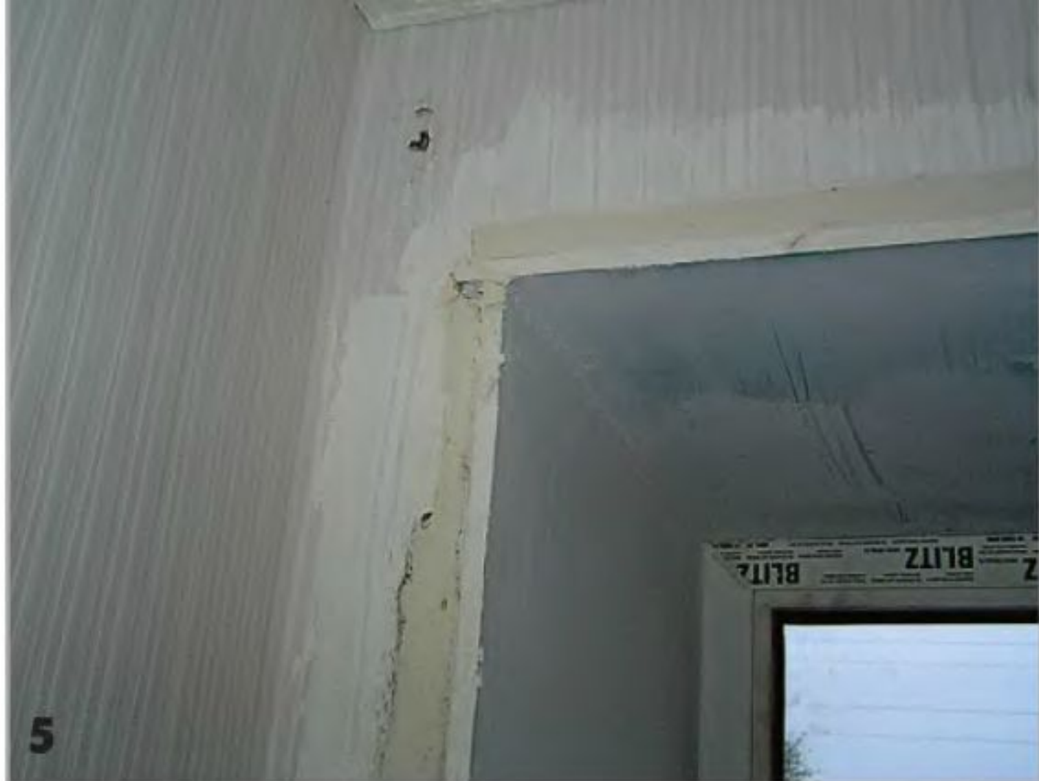
Неровности на стенах по всему периметру оконного проёма заштукатуривают универсальной гипсовой штукатуркой «Ротбанд».
