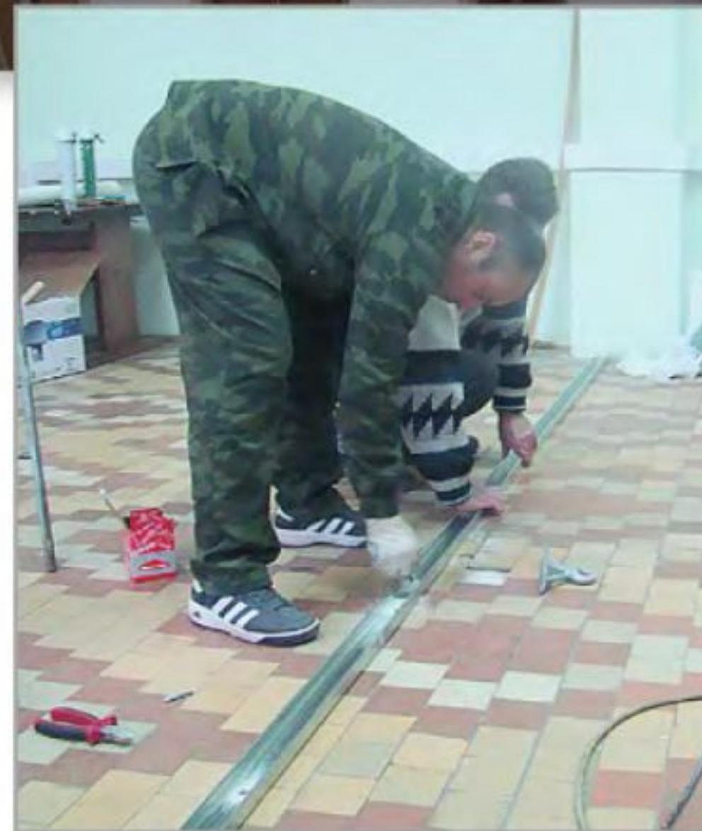
Для установки перегородки из панелей на полу, стенах и потолке монтируют металлические профили.
