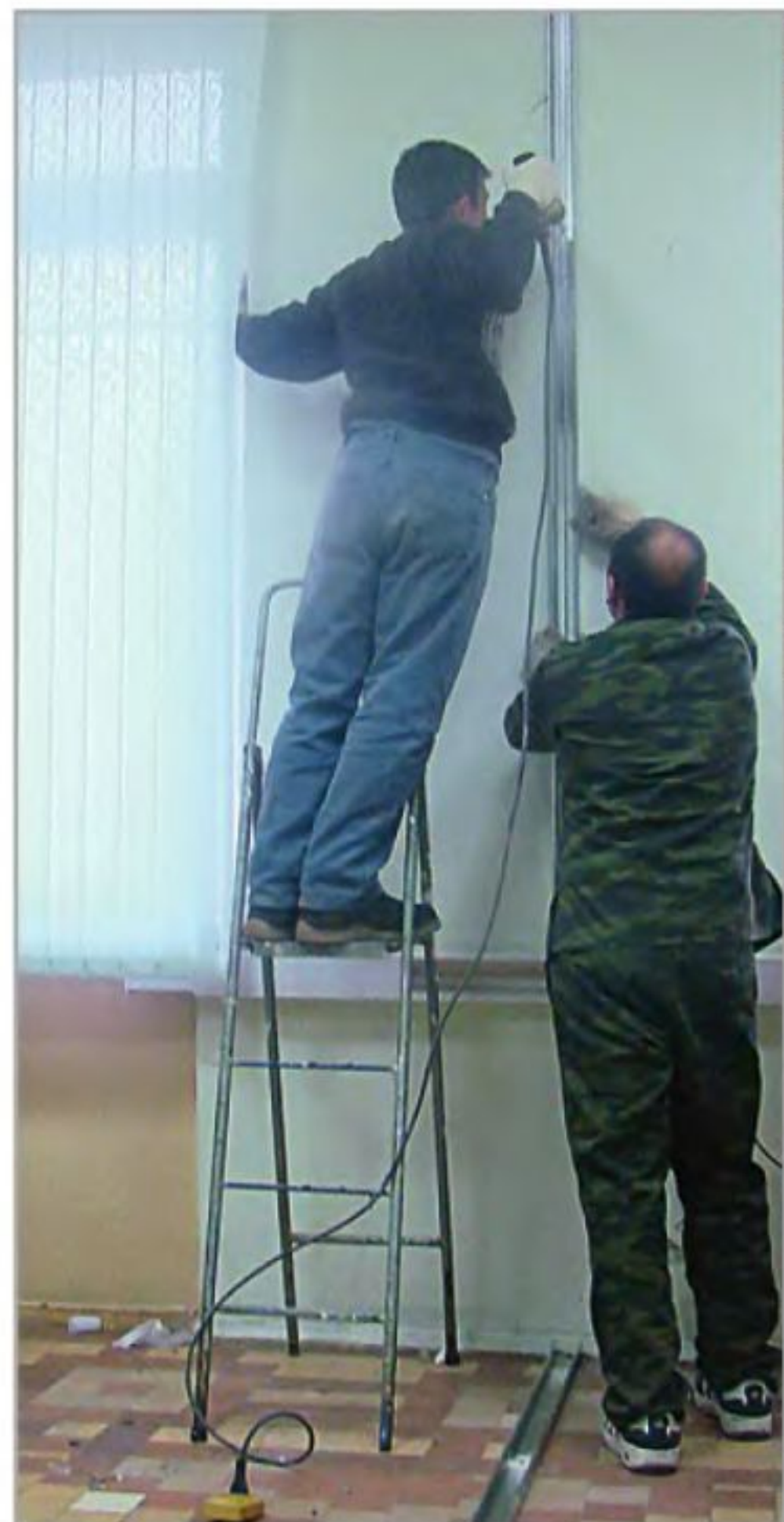
Для установки перегородки из панелей на полу, стенах и потолке монтируют металлические профили.
