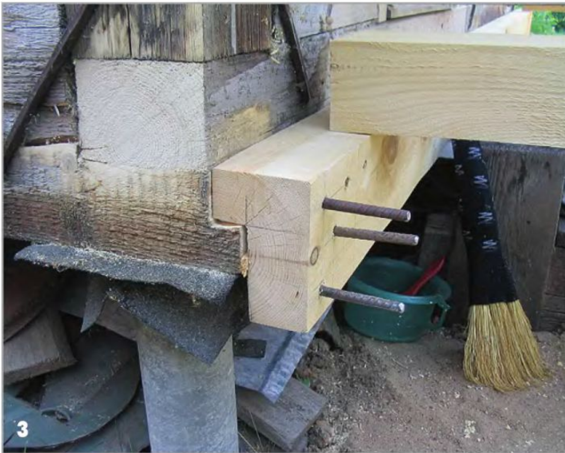
Крепление продольной балки нижней обвязки к срубе.
