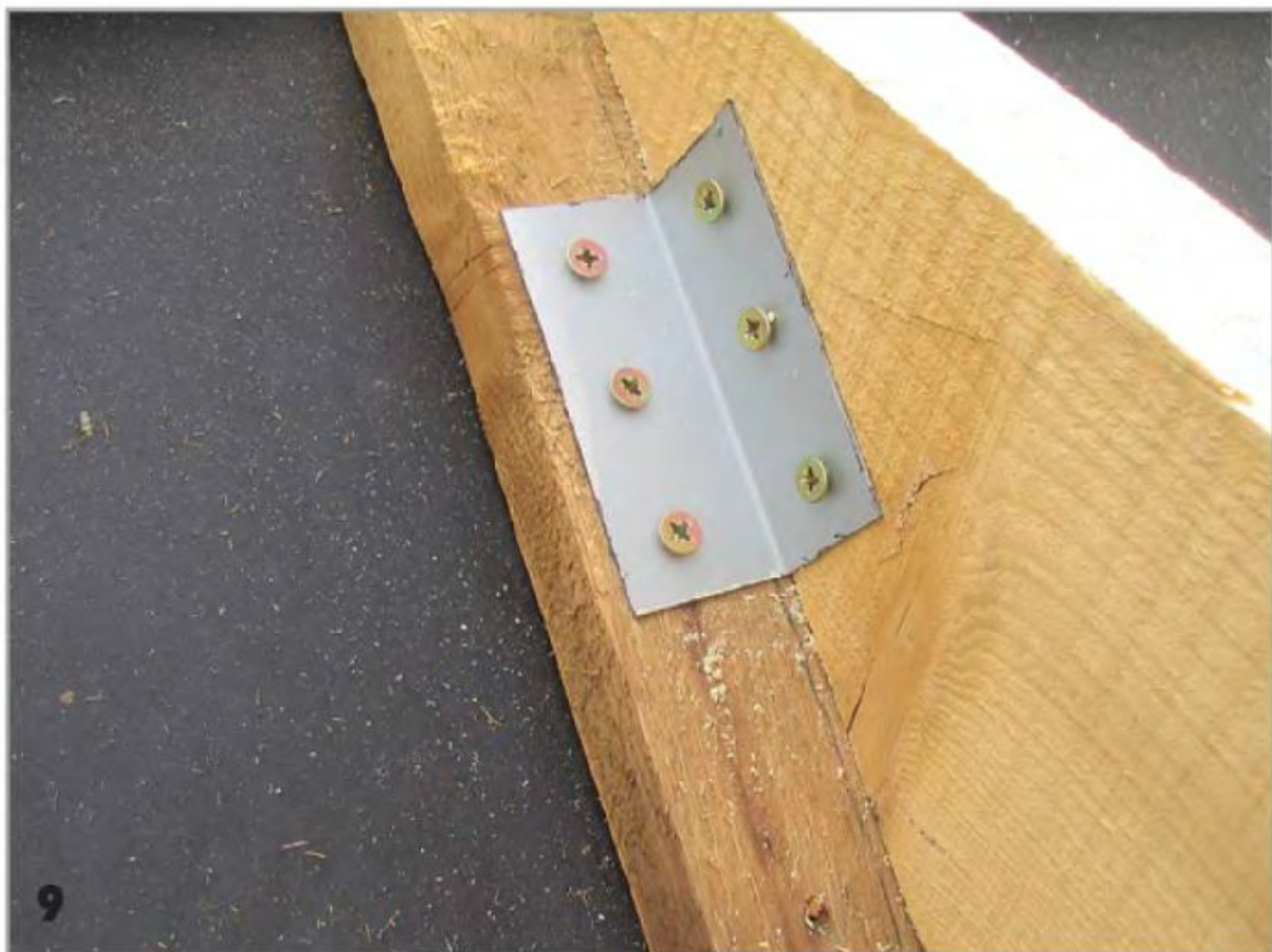
Крепление стропил веранды к стропилам крыши бани.
