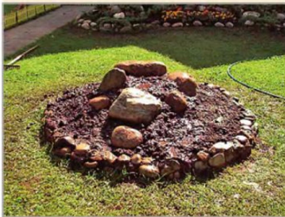
Укладка части плодородного грунта, камней и проливка альпинария для уплотнения дренажа и осадки камней. Оставшийся плодородный грунт вносится после осадки камней.
