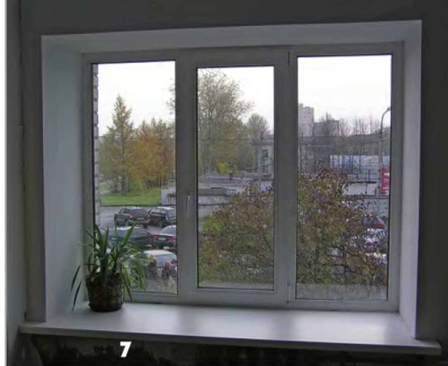
Вид окна после покраски откосов.
