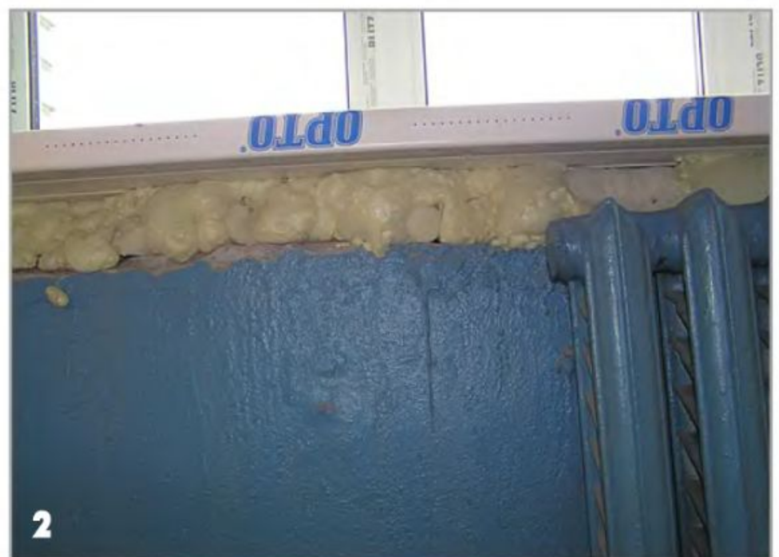
Установка подоконника и заполнение пустот пеной.
