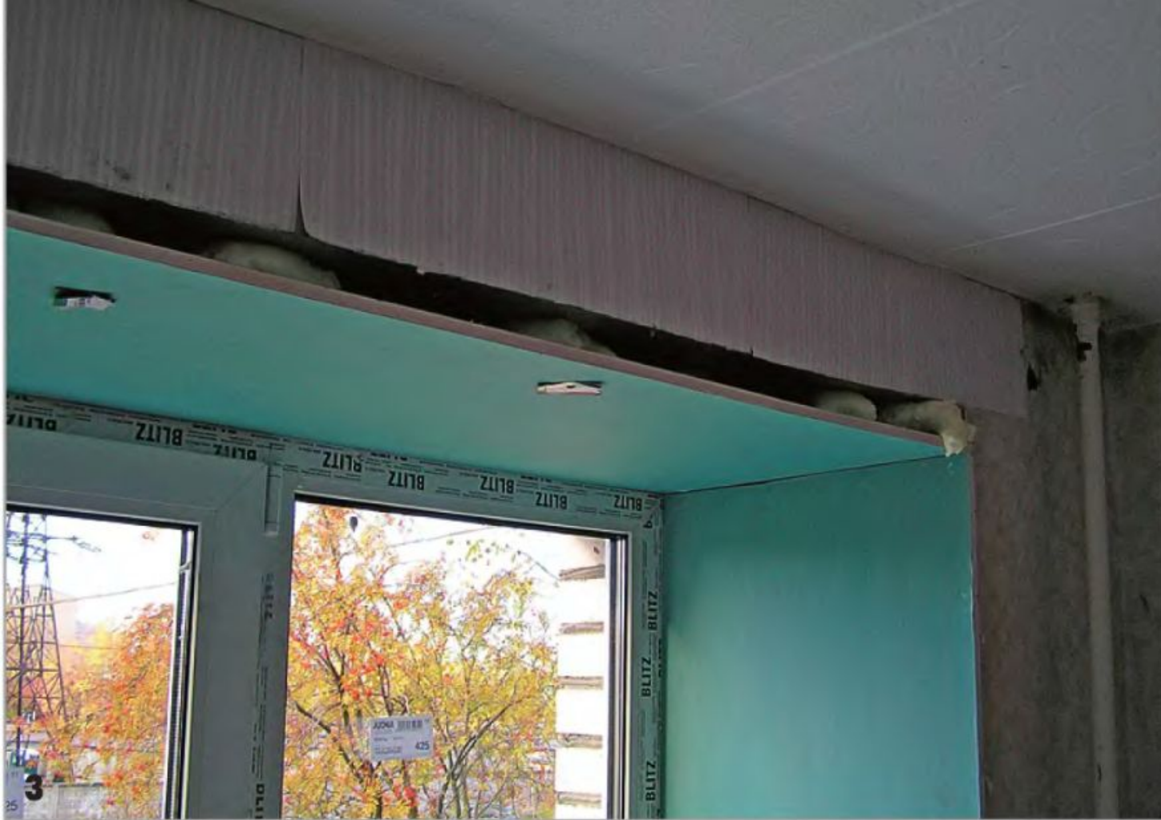
Первой устанавливают верхнюю горизонтальную панель из гипсокартона и фиксируют её двумя саморезами.
