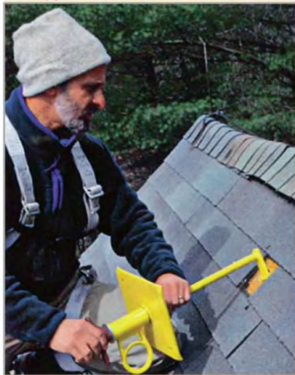
Для установки анкера на крыше удаляют часть мягкой кровли и просверливают отверстие в обшивке с тем, чтобы просунуть его сквозь кровлю рядом со стропильной ногой.
