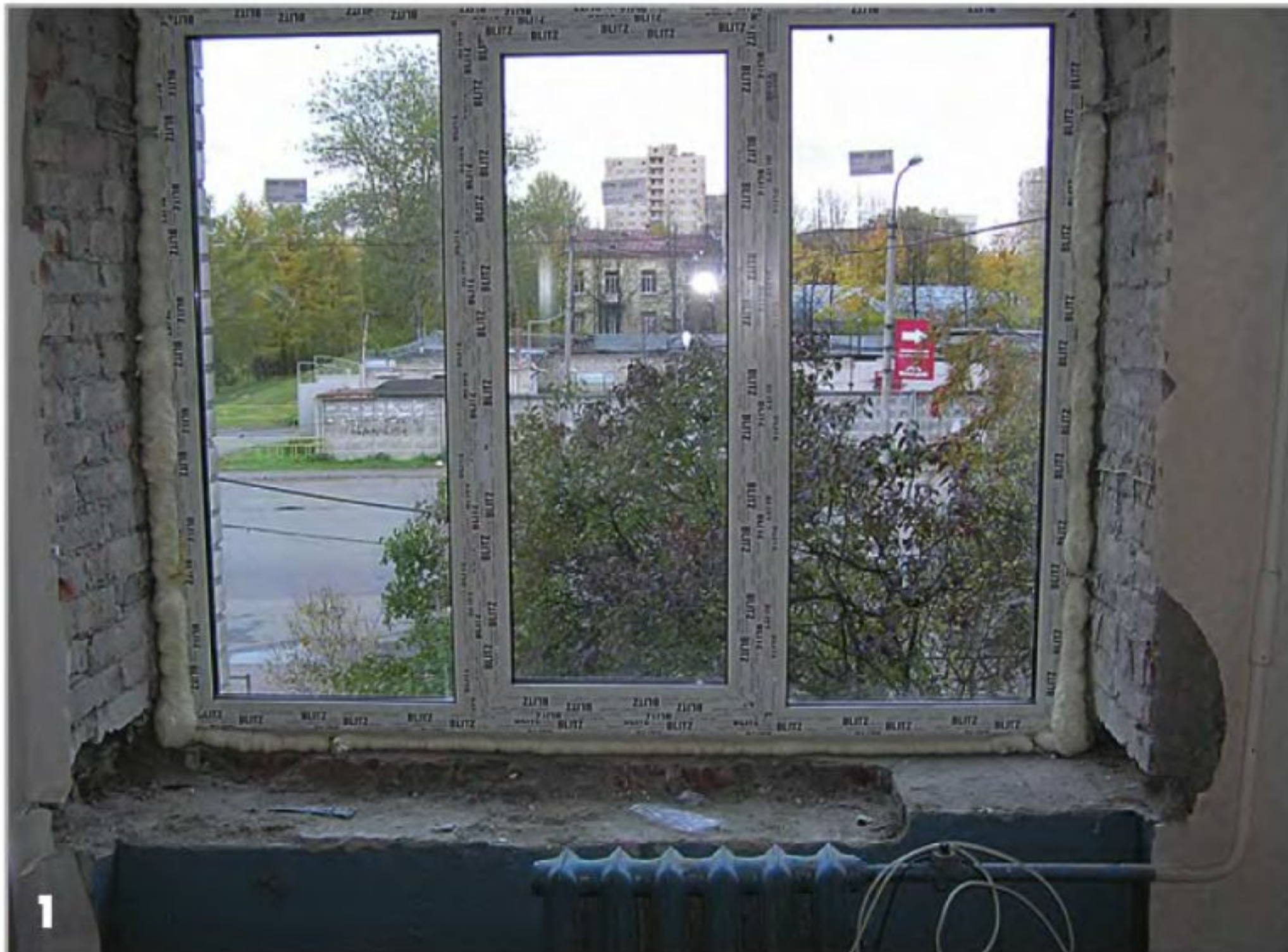
Вид оконного проёма после демонтажа старого окна и установки нового оконного блока.
